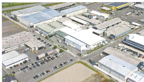
グループ企業2社の鳥取倉吉工場(鳥取県倉吉市)。左上のグレーの屋根:廣川マテリアル(株)、中央の白い屋根:株エースパック。環境対応型シートから容器までの一貫生産が可能
